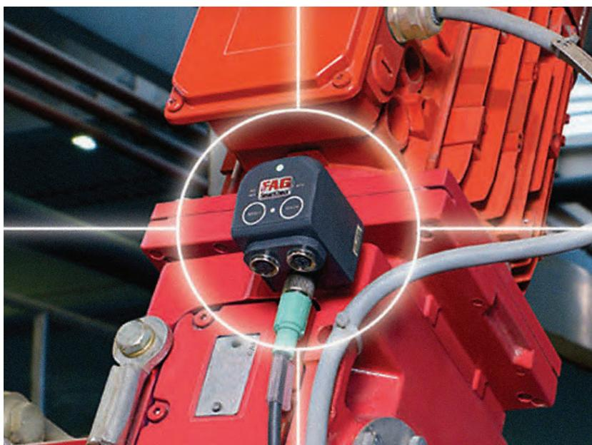
Блок датчиков SmartCheck очень просто монтируется с помощью винта в верхней части двигателя или редуктора и подключается с помощью одного кабеля по технологии Power over Ethernet (PoE).
